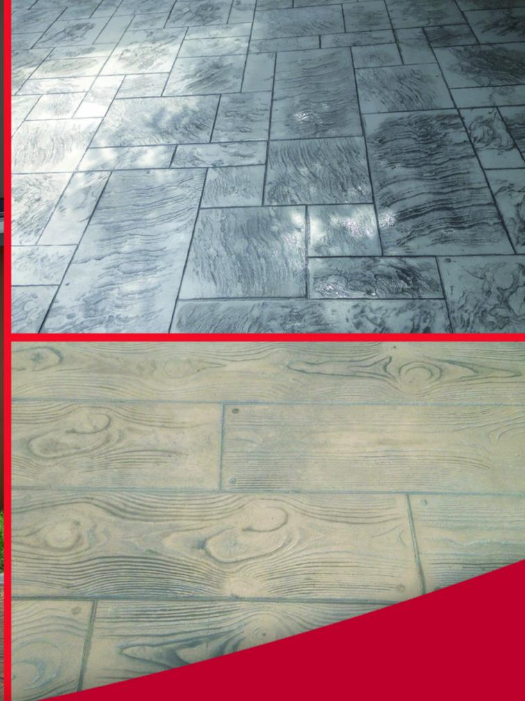
Le béton imprimé est obtenu à partir d'un béton frais, que l'on peut colorer, par l'application et le talochage de matrices qui donnent un aspect de relief à la dalle.
