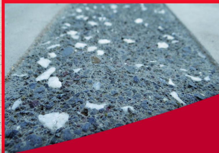
Le béton sablé est un béton qui s'intègre parfaitement à l'environnement. Il se caractérise par la mise à nu du granulat et du sable de façon superficielle. Après un durcissement du béton, un traitement mécanique est réalisé par sablage. Selon la force de projection la texture du béton est plus ou moins profonde. La sableuse projette à son tour sur le béton durci, des matériaux abrasifs.
